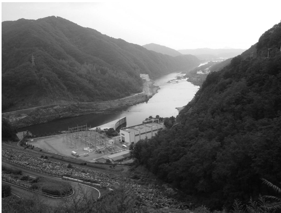
FIGURA 7.9 – RESERVATÓRIO HWANCHON, LOCAL DE INTENSAS BATALHAS, NAS OFENSIVAS NORTE-AMERICANAS
